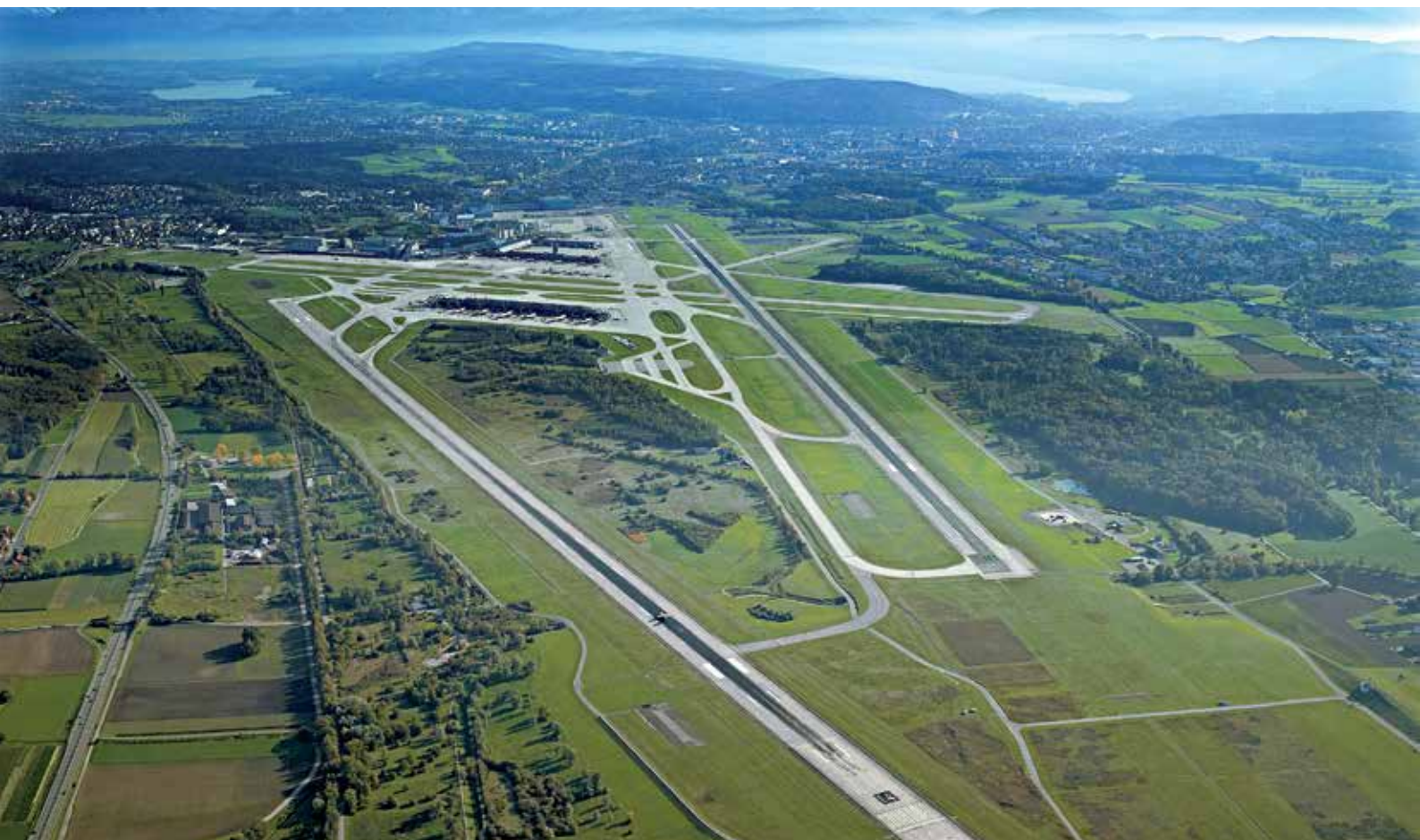
Der Flughafen Zürich verfügt über ein komplexes und ein nicht ganz einfach zu arbeitendes Pistensystem. Photo: Flughafen Zürich
